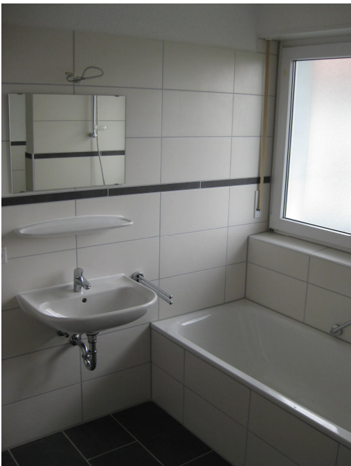
Moderne Boden und Wandfliesen
