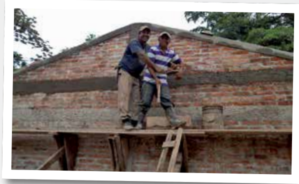
Gemeinsam mit Schulvätern haben lokale Handwerker eine Grundschule im Dorf Casa Piedra/Nicaragua errichtet.
